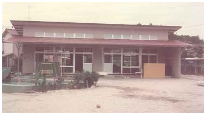
増築が完了しました。
