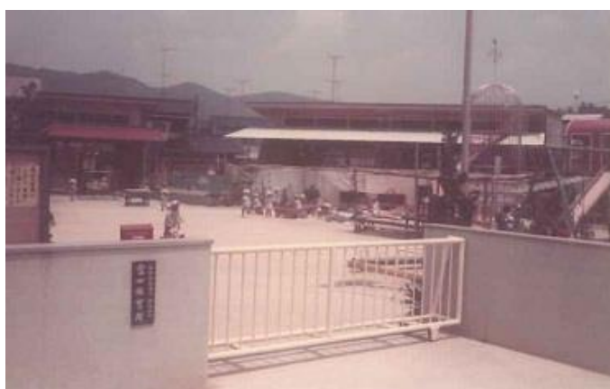
こどもの数が増えたため、現在の職員室あたりの福山市の土地を購入。増築工事をしています。
